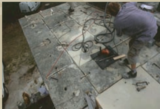
V roce 2007 probíhala oprava horní části.
