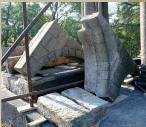
Stav v roce 2006, rozebírání kamenné arkády.
