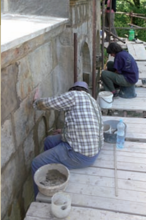
Obnova kamenného pláště – 2008.
