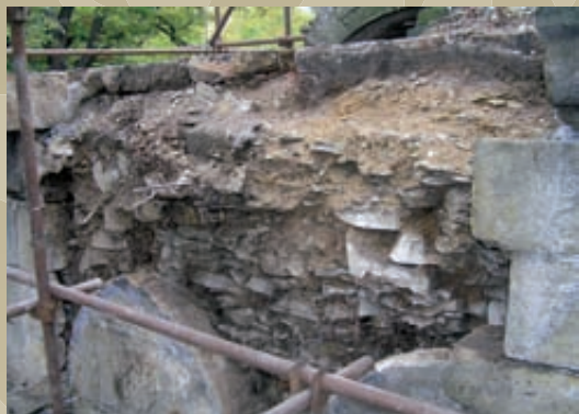
2006 – Rozebírání staticky narušeného zdiva.
