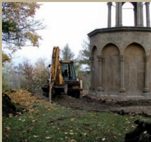
Úprava okolí v roce 2010.
