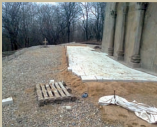
Pokládání žulové dlažby v roce 2010.
